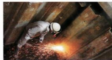
シートパイル溶断
